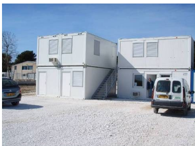
Installation de chantier : laboratoire, salle de réunion, bureaux de l'entreprise et du maître d'œuvre.
