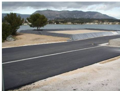
Réalisation de voiries
