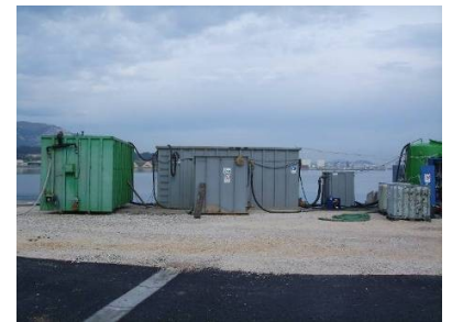
Mise en place d'une unité de traitement des eaux
