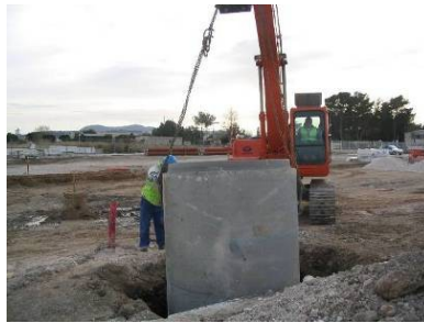
Mise en place des réseaux - VRD
