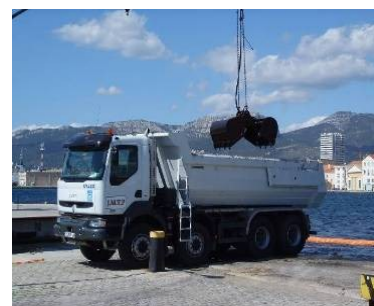
Chargements des sédiments dans des camions équipés de bennes étanches
