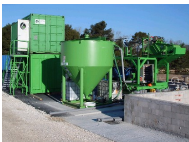
Installation des machines de traitements
